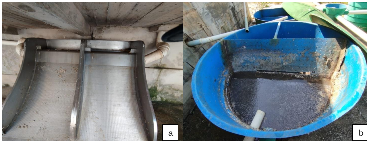
FOTO 1 – Tratamento Primário composto por peneira estática (foto a) e caixa gradeadora (Foto b).
